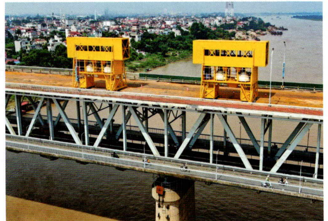
Ứng dụng trạm trộn bê tông siêu tính năng (UHPC) kiểu di động trong sửa chữa mặt cầu Thăng Long.
