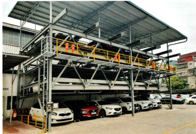
Hệ thống bãi đỗ xe ô tô tự động.
